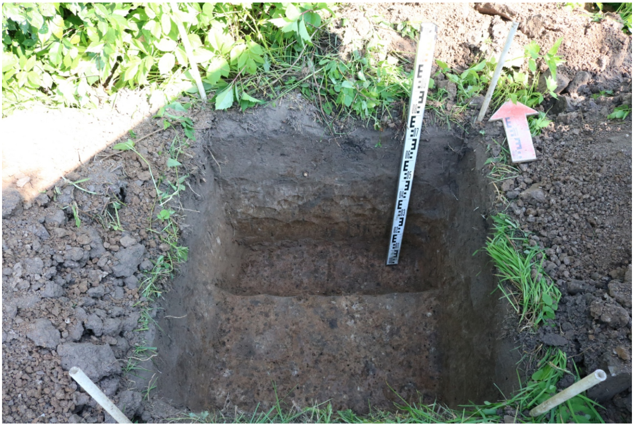
Рис. 28. Археологическое обследование участка по объекту: «Уличные газопроводы дер. Бражниково Бабынинского района Калужской области». 2023 г. Шурф 1. Материк (контрольный прокоп). Вид с Ю.
