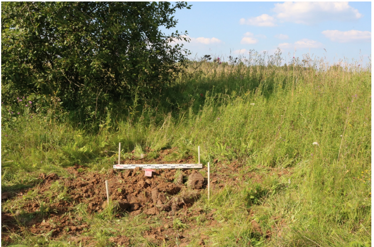
Рис. 45. Археологическое обследование участка по объекту: «Уличные газопроводы дер. Бражниково Бабынинского района Калужской области». 2023 г. Шурф 4. Рекультивация. Вид с Ю.
