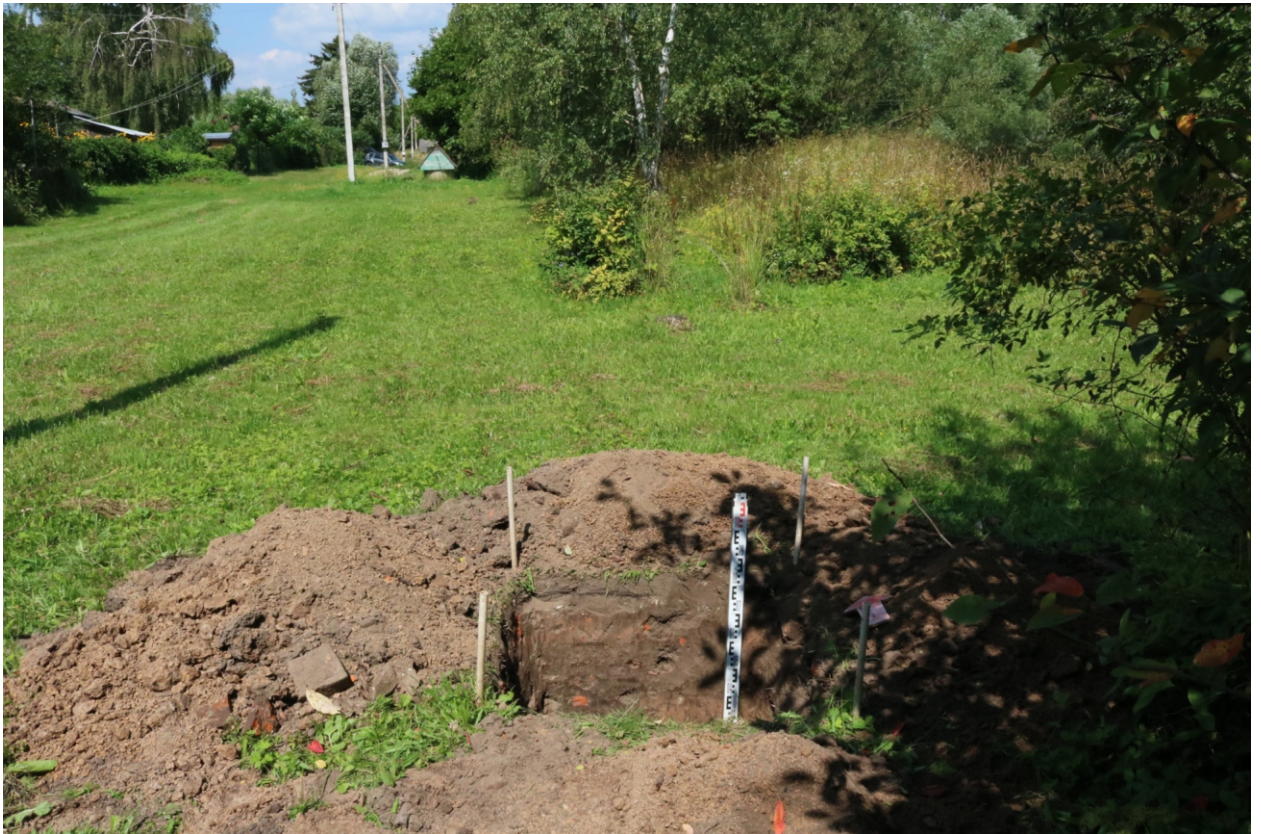
Рис. 32. Археологическое обследование участка по объекту: «Уличные газопроводы дер. Бражниково Бабынинского района Калужской области». 2023 г. Шурф 2. Общий вид с Ю после завершения работ.
